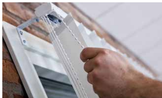
Skenan är liksidig vid manuella system, vilket gör den vändbar. Linans och kulkedjans placering är det enda som påverkas.
